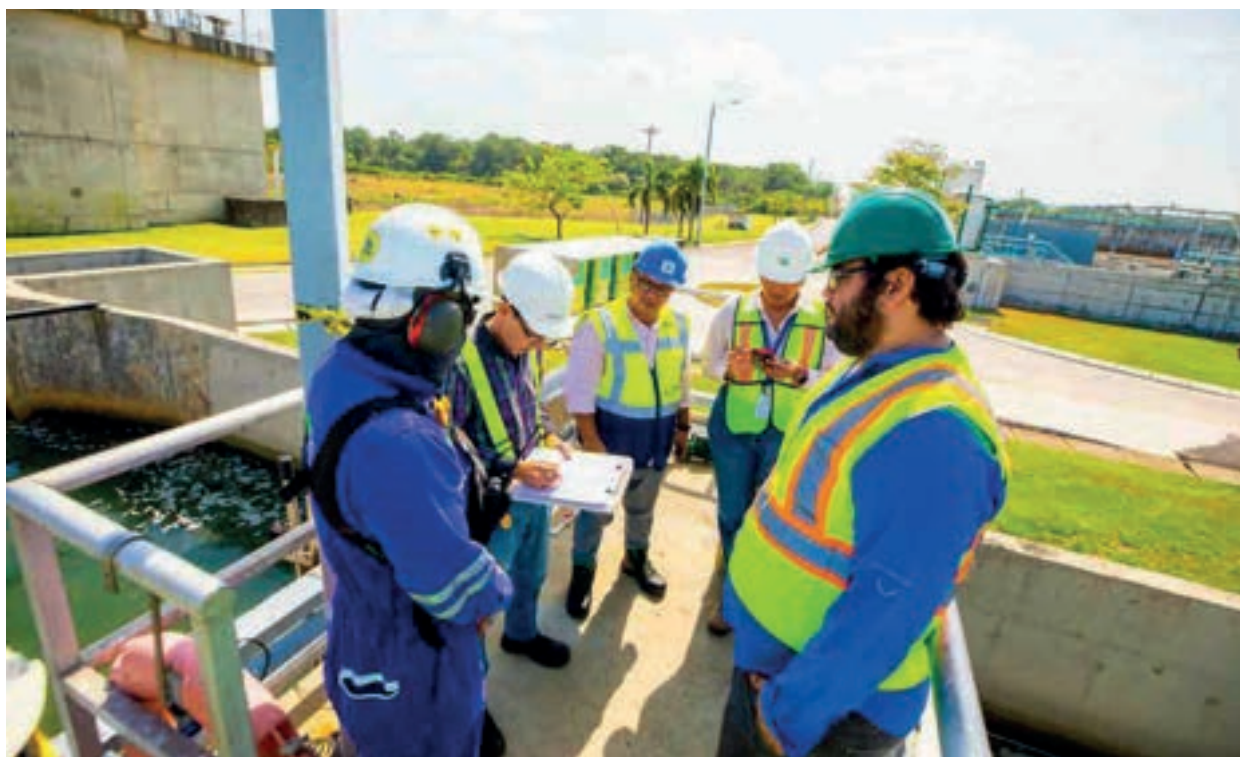
Operación en la Planta de Tratamiento de Aguas Residuales de Juan Diaz
