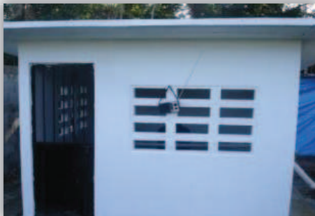
Caseta para filtros de arena a presión comunidad de Caimito Costa Abajo de Colón y de Palmira Costa Abajo de Colón.
