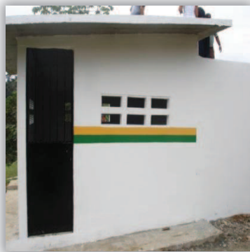
Acueductos en la Región de Panamá Oeste
